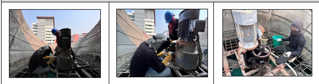
ภาพที่ ค-9 บำรุงรักษาหอระบายความร้อนระบบปรับอากาศ ระหว่างเดือนมกราคม - มิถุนายน 2566
