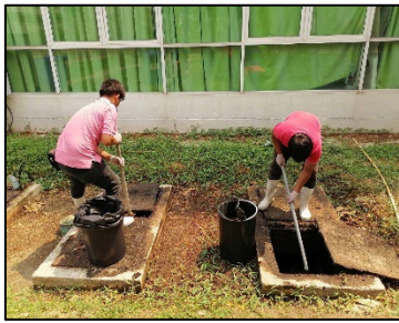
ภาพที่ ค-10 บำรุงรักษาบ่อตกไขมัน บ่อพักน้ำเสียและระบบระบายน้ำโดยรอบอาคาร ระหว่างเดือนมกราคม – มิถุนายน 2566
