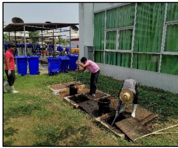
ภาพที่ ค-10 บำรุงรักษาบ่อตกไขมัน บ่อพักน้ำเสียและระบบระบายน้ำโดยรอบอาคาร ระหว่างเดือนมกราคม – มิถุนายน 2566
