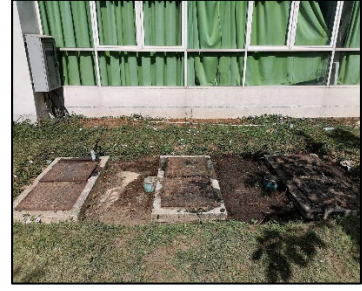
ภาพที่ ค-10 บำรุงรักษาบ่อตกไขมัน บ่อพักน้ำเสียและระบบระบายน้ำโดยรอบอาคาร ระหว่างเดือนมกราคม – มิถุนายน 2566
