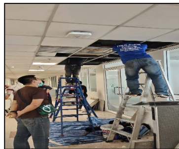
ภาพที่ ค-3 การทำความสะอาดเครื่องปรับอากาศ ระหว่างเดือนมกราคม – มิถุนายน 2566
