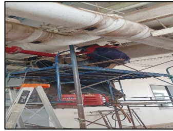
ภาพที่ ค-17 ปรับปรุงระบบท่อดับเพลิง ระบบอัคคีภัย ระหว่างเดือนมกราคม – มิถุนายน 2566
